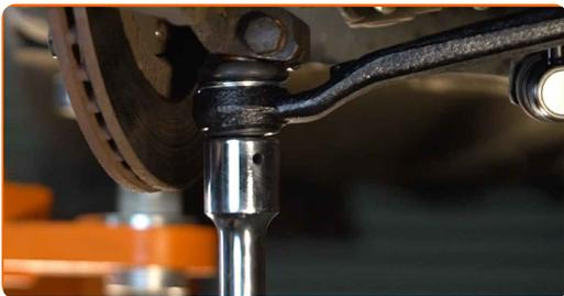
**28** Σφίξτε το εμπρόσθιο στοιχείο στερέωσης που συνδέει το βραχίονα ελέγχου με το υποπλαίσιο. Χρησιμοποιήστε ένα καρυδάκι #18. Χρησιμοποιήστε ένα δυναμόκλειδο. Σφίξτε τη με ροπή 74 Nm.
